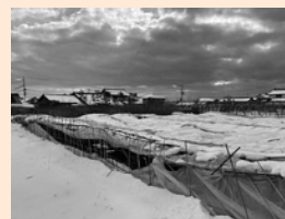
大雪で倒壊したハウス
