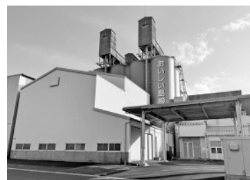
黒目カントリーエレベーター （斐川町黒目地内）
