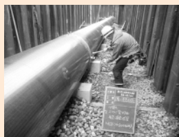
配管工事のようす
