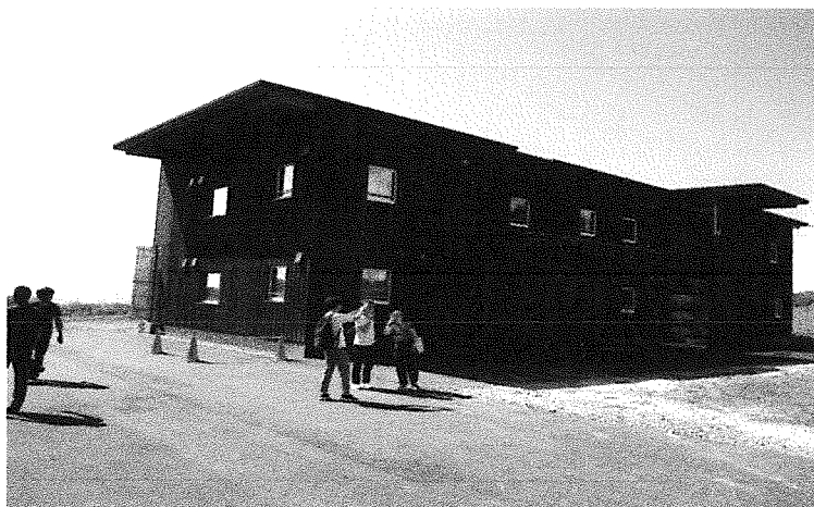
高断熱住宅（外観）
