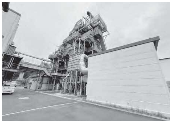
松江バイオマス発電所
