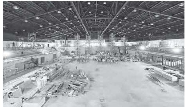
建設中の出雲市総合体育館
