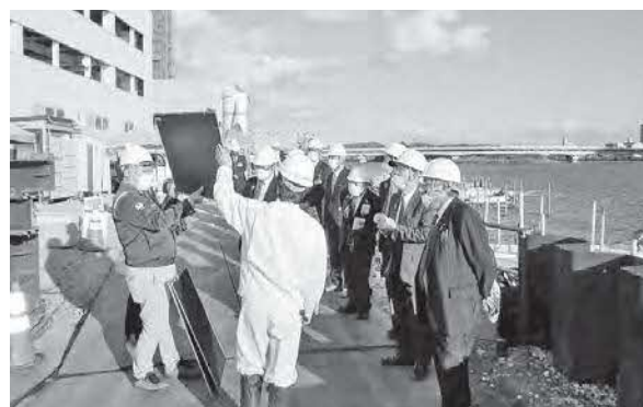
東本町工事現場での現地視察のようす（松江市）
