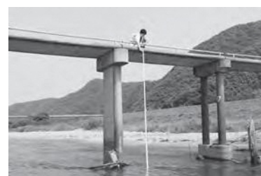
約 4 m 河床低下した山田橋地点
