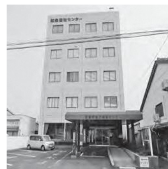
老朽化が進んでいる社会福祉センター
