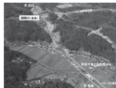
山陰道 湖陵 IC（仮称）付近 （国土交通省中国整備局 HP から引用）
