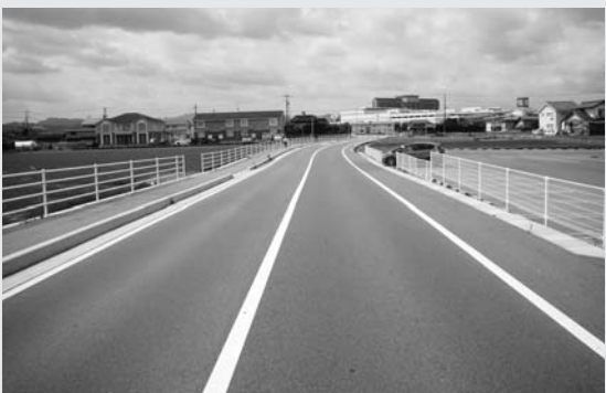
「第1次幹線市道整備10か年計画」で整備した北本町谷田合線
