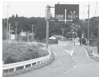
県道・市道・農道が交差する新工業団地予定地（斐川インターチェンジ付近）
