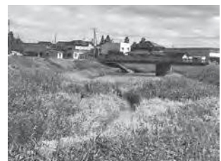
河道に繁茂する樹木など (平田町なめら橋付近)
