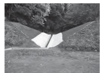
廃止工事が完了したため池
