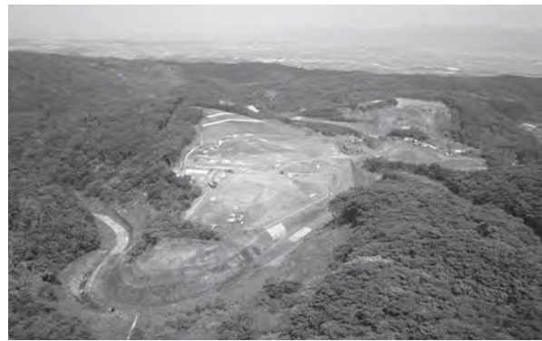
次期可燃ごみ処理施設敷地造成工事および古志 86 号線外道路改良工事（6 工区）のようす
