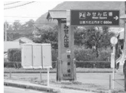
みせん広場の仮設トイレ
