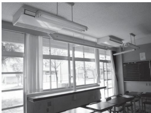
エアコンが整備された教室
