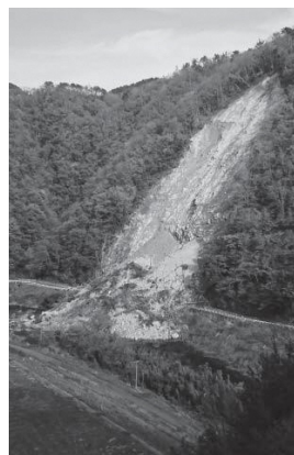
地震被害で通行止めになった佐田町市道門曲線
