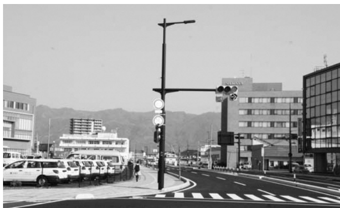
県街路事業で整備した出雲市駅前矢尾線
