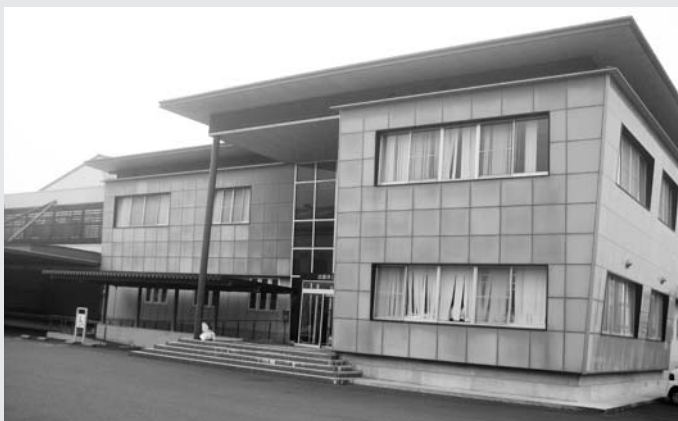
食器洗浄システムを更新する出雲学校給食センター
