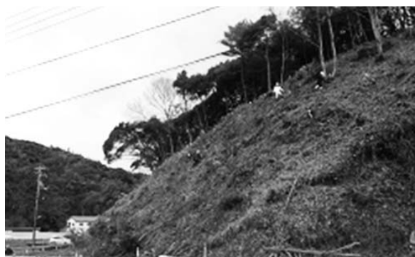
森林・山村多面的機能発揮対策事業で行われた里山整備
